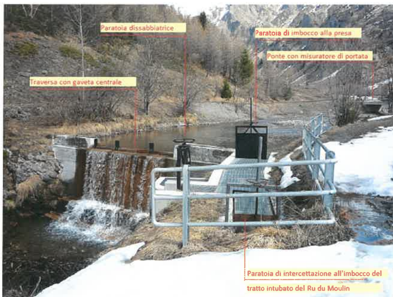
Vista da valle dell'opera di presa del Ru du Moulin sul torrente Grand Eau
